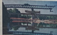
SPIC . Costruzione del ponte sul fiume Tagliamento in località Latisana (UD) per l'opera di realizzazione della 3ª corsia dell'autostrada A4 tratto Venezia-Trieste
